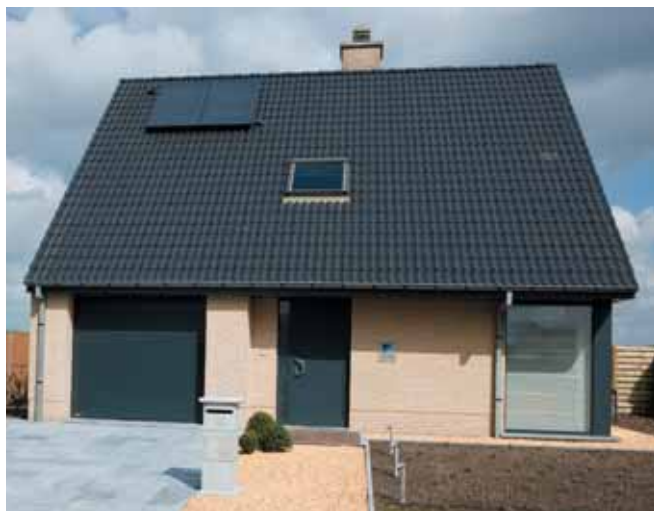
Maison test de Daikin pour mesurer les performances de ses innovations.
